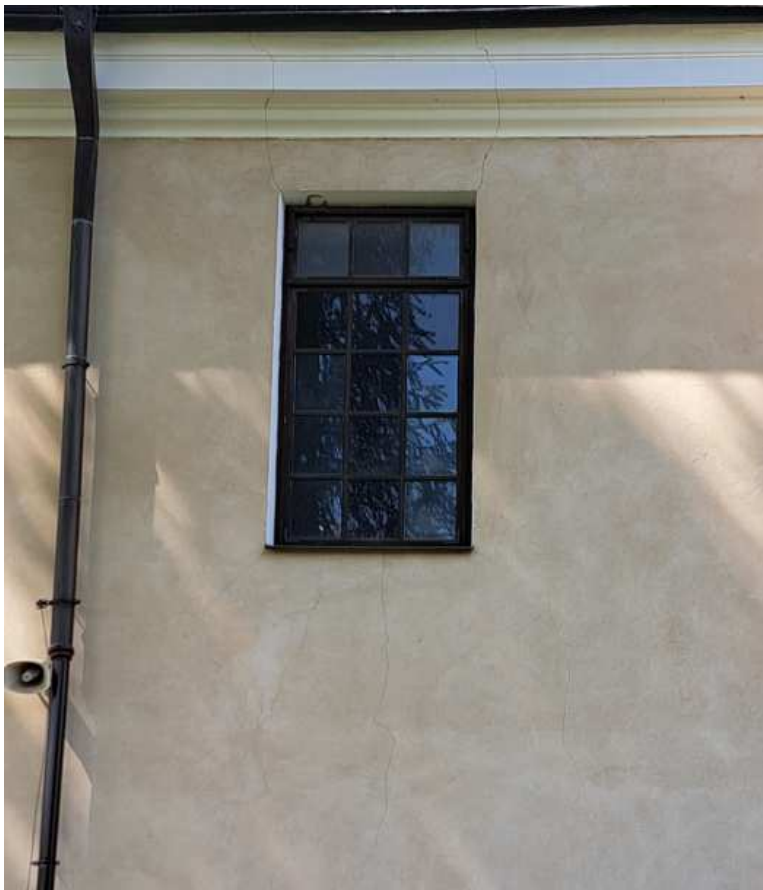
Fot. 2 Pęknięte tynki zewnętrzne w okolicy okien
