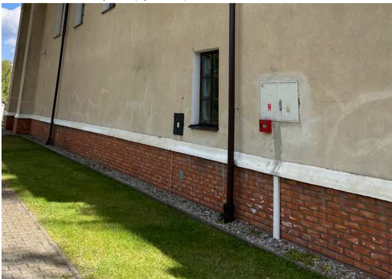
Fot. 4 Spękanie tynku strefy przycokołowej
