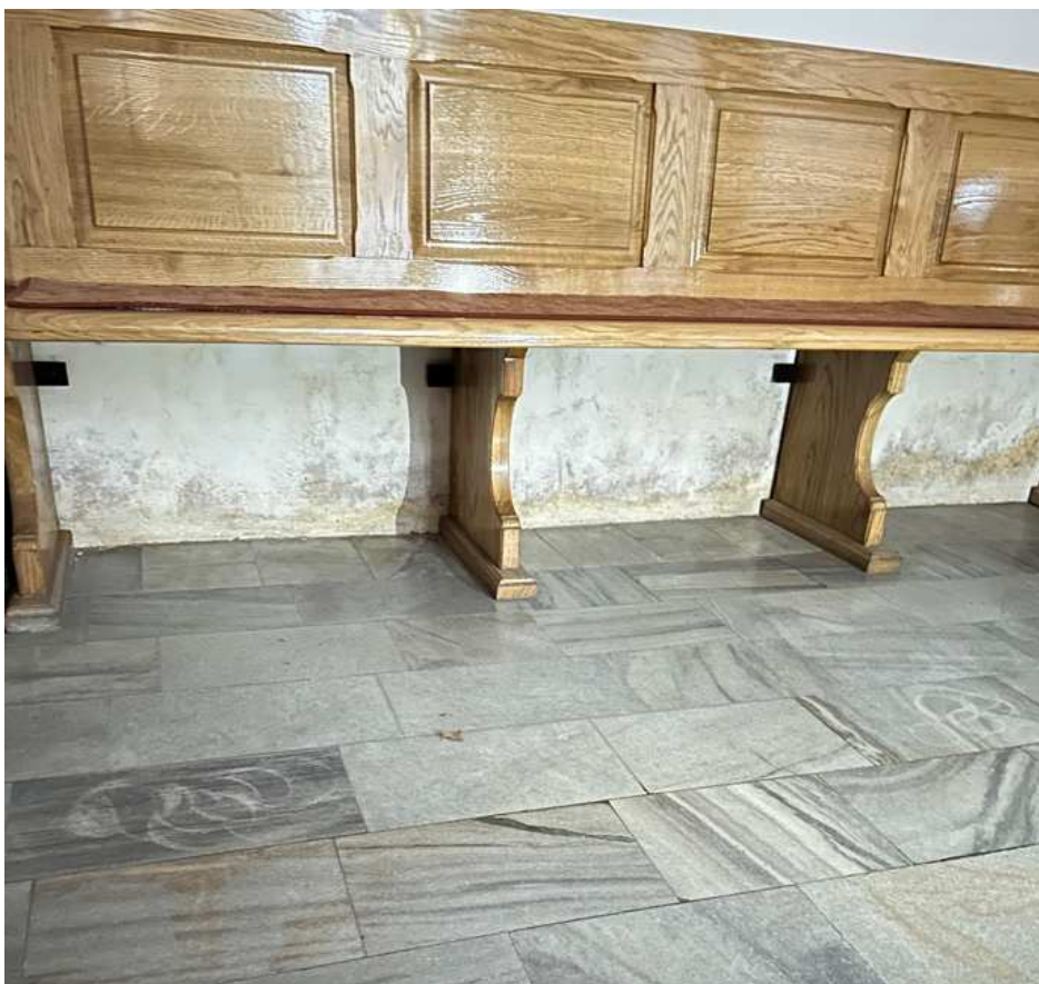
Fot. 8 Zagrzybienia i zawilgocenia ścian
