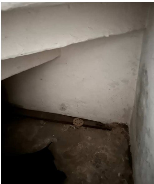
Fot. 7 Zagrzybienia i zawilgocenia pod schodami
