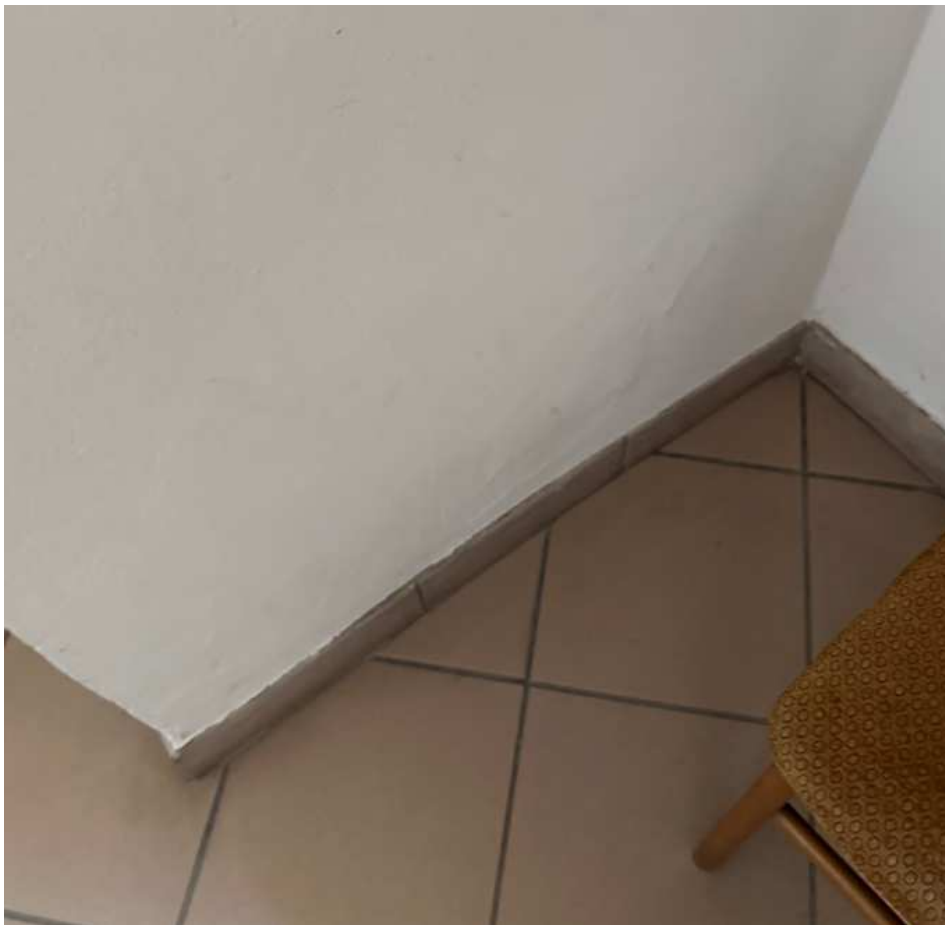
Fot. 5 Pęcherze powietrza pod tynkiem wewnętrznym
